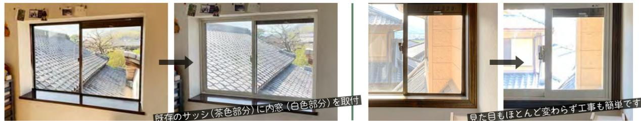
2階のすべての窓に内窓(二重窓)を取り付けた改修工事。この工事は「開口部(窓・玄関ドア)の断熱改修」の「内窓設置」にあたり、1カ所につき14,000~21,000円の補助金が交付されます。(窓の面積により補助額が異なります。)その他「外壁・屋根・天井又は床の断熱改修」「エコ住宅設備の設置」「子育て対応改修」「耐震改修」「バリアフリー改修」「空気清浄機能・換気機能付きエアコンの設置」等お得な工事がたくさん! もちろん子育て世帯以外も対象! 詳しくは「こどもみらい住宅支援事業」で検索♪
