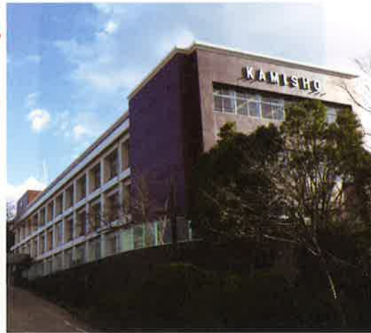
「つぼや流56号」でご紹介した上高瀬小学校の耐震工事が完了しました。
