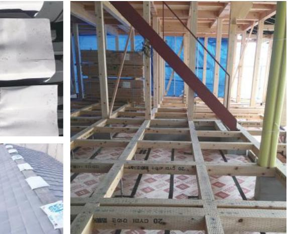
内部では、床下断熱材を敷き込み、ジョイント部分は気密テープで処理ていきます。
