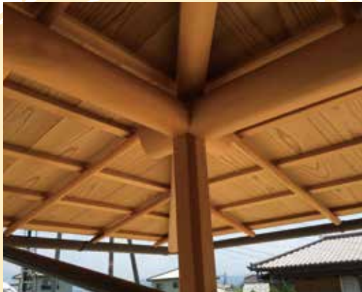
玄関下屋根。杉丸太化粧軒天井。匠の技が映える。
