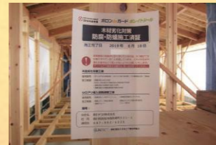
内部の骨組みの、防蟻・防腐処理が完了しました。
