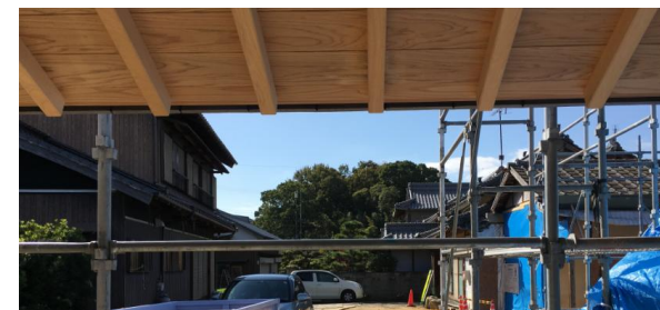
玄関取次より前方の森を見る
