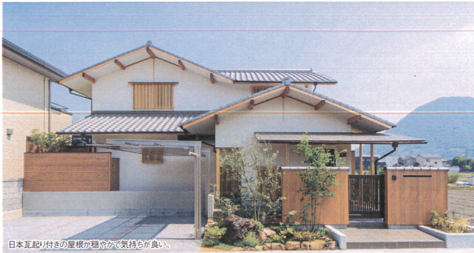
明治9年に建てられた古民家を全面改修し、四国化成第18回施工作品コンテストにおいて内装部門優秀賞を受賞。
