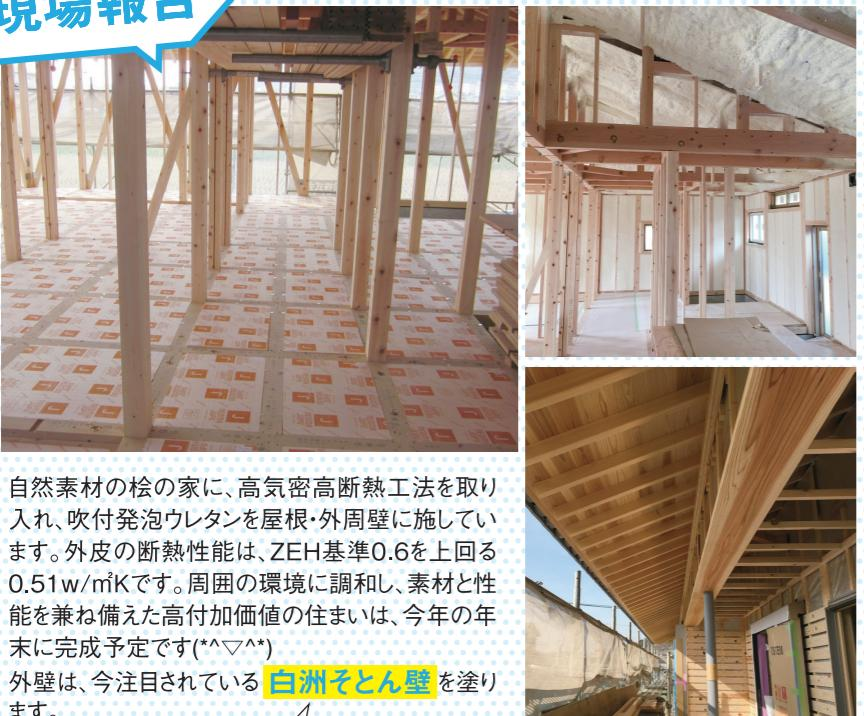
自然素材の桧の家に、高気密高断熱工法を取り入れ、吹付発泡ウレタンを屋根・外周壁に施しています。外皮の断熱性能は、ZEH基準0.6を上回る0.51w/m<sup>2</sup>Kです。周囲の環境に調和し、素材と性能を兼ね備えた高付加価値の住まいは、今年の年末に完成予定です(\*^▽^\*)
